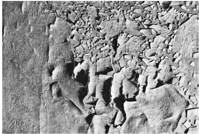
亀裂、剥離、剥落が著しい（背景：空の部分）
